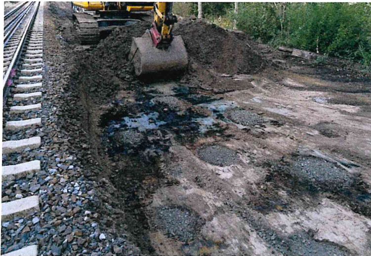
Bild 9 Blick auf den Abschnitt 5 während des Bodenabtrages oberhalb der Rüttelstopfsäulen zum Einbau der Ausgleichsschicht und des lastverteilenden geogitterbewehrten Tragschichtsystems. Die kleinräumig stark wechselnden Baugrundverhältnisse sind gut zu erkennen.
