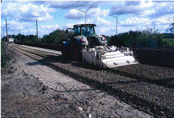
Bild 8 Blick auf den Abschnitt 1 während des Einfräsens des Bindemittels. Links im Bild zu erkennen ist das Ausstreufahrzeug, welches das Bindemittel zuvor gleichmäßig ausbringt.
