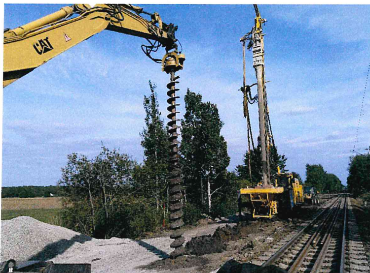
Bild 10 Blick auf die Herstellung der Rüttelstopfsäulen.
